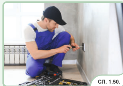
ЕЛЕКТРИЧАР МЕЊА НЕИСПРАВНУ УТИЧНИЦУ
